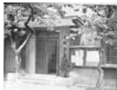
舊夜間部辦公室 (已拆除) (資料來源：《師大概況》55年版) The office of the night school (now demolished) (Source: NTNU Overview, 1966)
