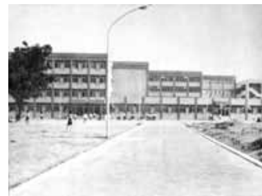
理學院大樓 (資料來源：《師大概況》65年版) Building of the College of Science (Source: NTNU Overview, 1976)
